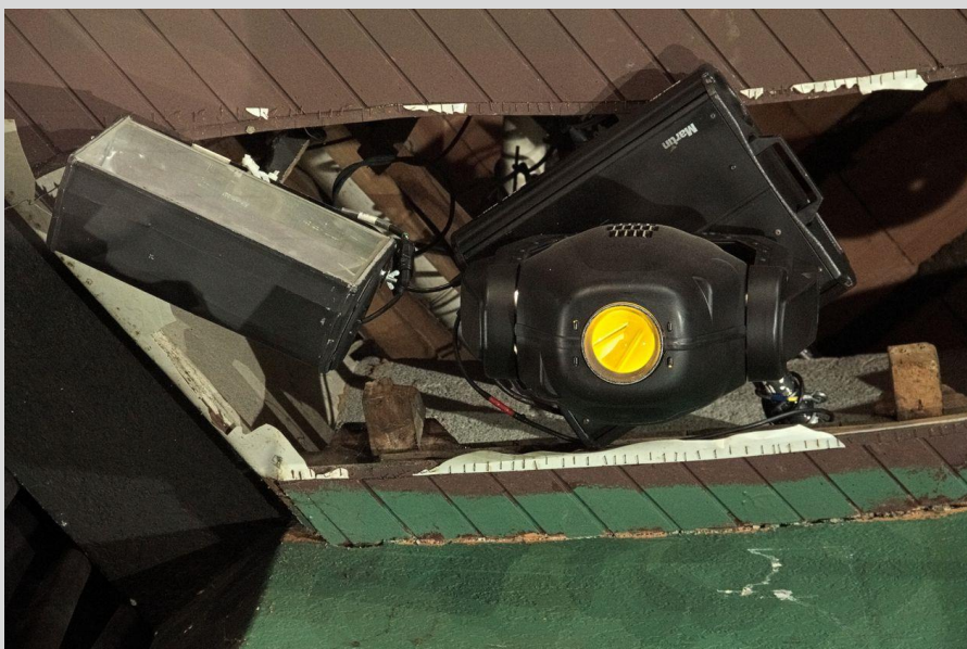
Instalação de Movings, lâmpadas PAR 64 e uso de carcaças velhas de antigos Fresneis/ PC para uso com lâmpadas PAR 64
