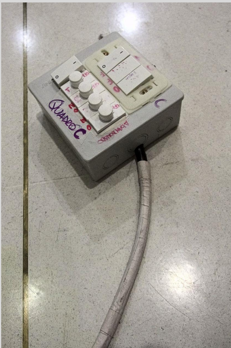
Caixa de “operação de luz” no Shopping.
