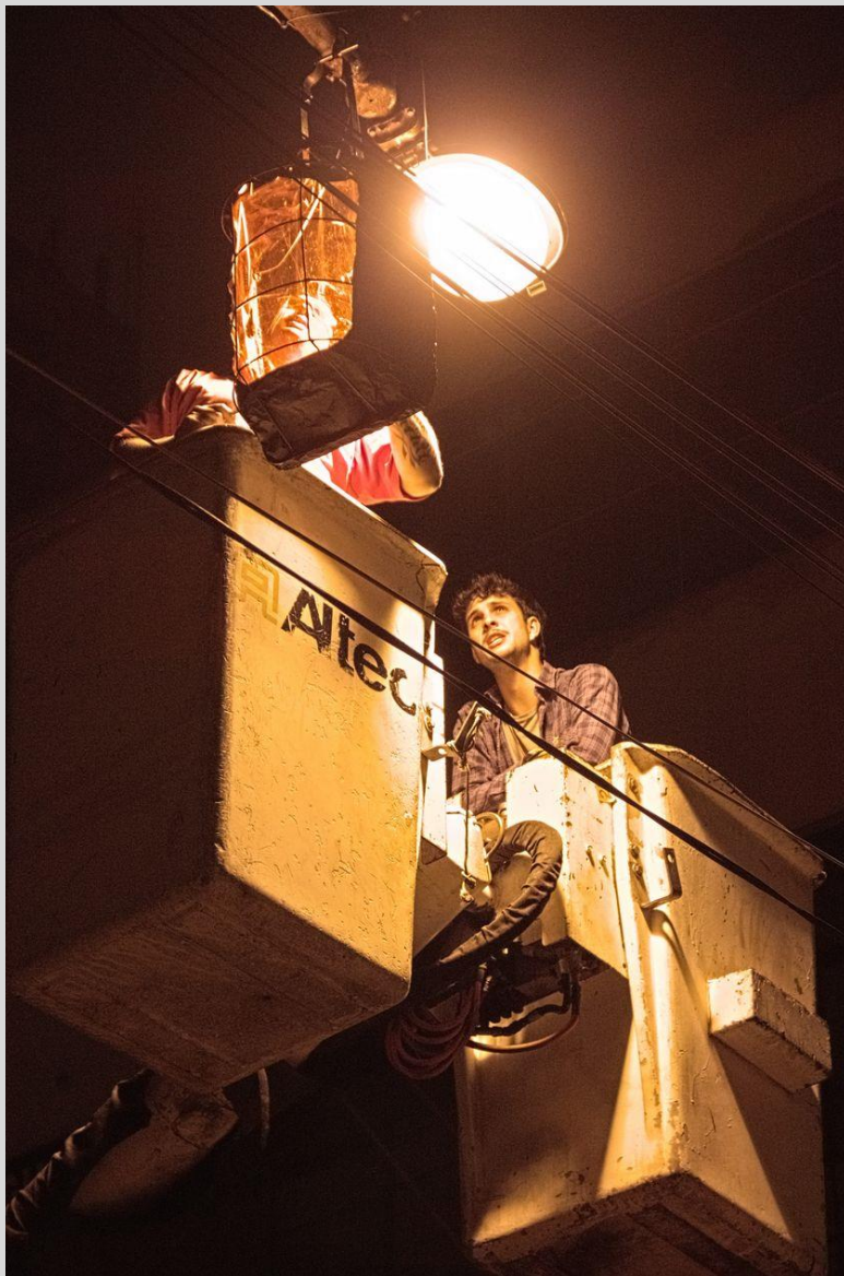
Pedro durante a montagem das traquitanas nos postes na Rua.
